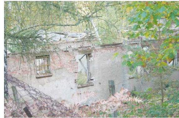
Reste der Zollbaracken unweit der Autobahn Dreilinden
